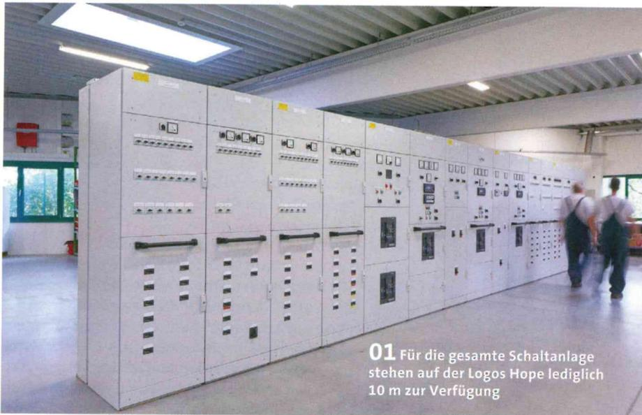
**01** Für die gesamte Schaltanlage stehen auf der Logos Hope lediglich 10 m zur Verfügung
